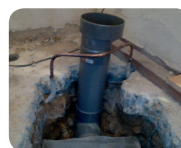
Mise en place du puisard
