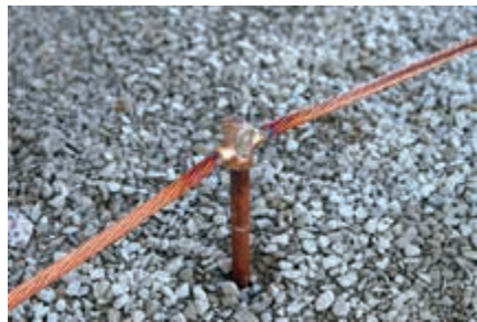
Les systèmes commerciaux de mise à la terre peuvent être dotés de câbles en cuivre ou plaqués cuivre, fusionnés à des tiges de mise à la terre en cuivre ou plaquées cuivre.
