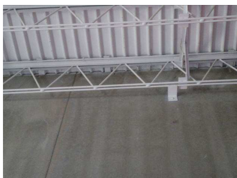
Situation intérieure: hauteur au-dessus le sol 6 m
