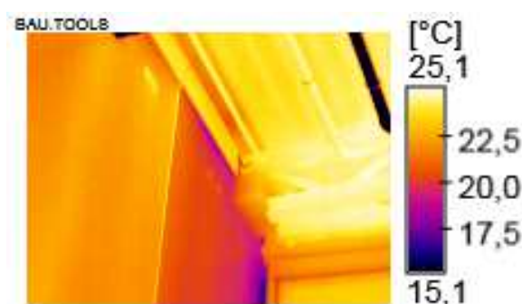
Thermogramme de départ
