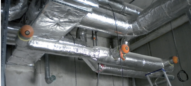
Figure 2 - Obturation d'un réseau de ventilation pour test d'étanchéité
