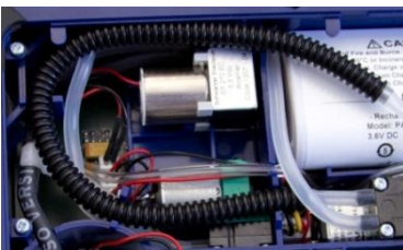
Ill. 80: Tuyau ondulé correctement posé
