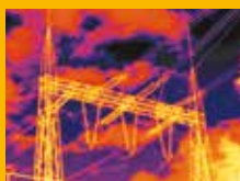
Inspection de lignes à haute tension
