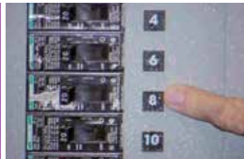
Le point chaud indique un court-circuit qui pourrait déclencher un incendie.
