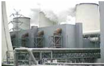
Inspection de l'isolation
