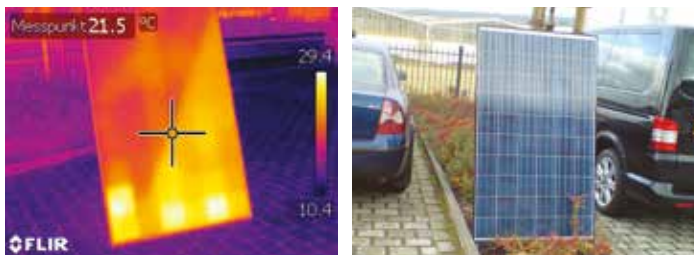
Les points chauds sont ici facilement visibles sur l'image thermique, même de face.
