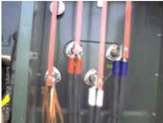
Les caméras thermiques permettent d'examiner tout le système d'installation, y compris les systèmes annexes de l'éolienne. Le connecteur de phase de droite est beaucoup plus chaud que les deux autres. Ce défaut a été identifié et réparé avant que la panne se produise.
