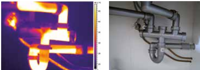
Détection des problèmes de plomberie par imagerie thermique.
