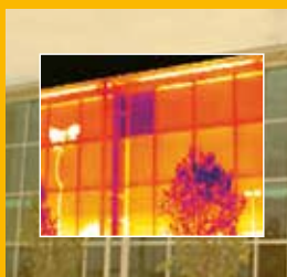
Inspection thermique d'une façade vitrée.
