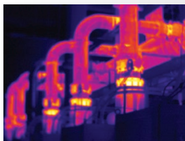
Mise au point manuelle
